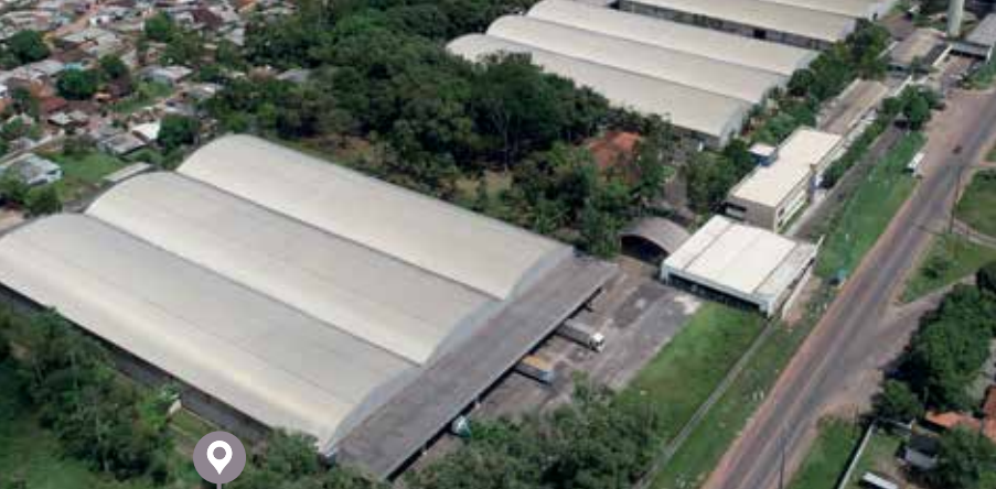
Unidade Fabril BELÉM | BELEM'S Plant | Unidad fabril BELÉM
